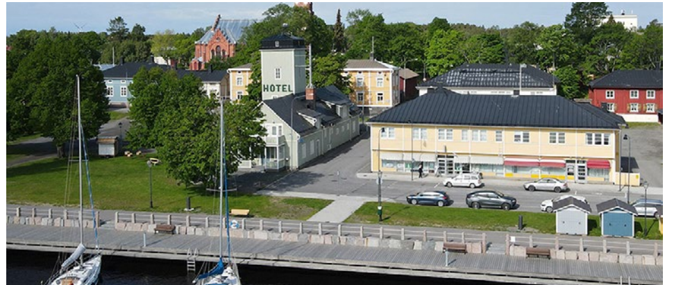
Luckan finns på Sjögatan i Kristinestad och verksamhetsområdet omfattar även Kaskö och Närpes.
